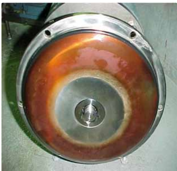
Misfarvning (rouging) af pumpehus
